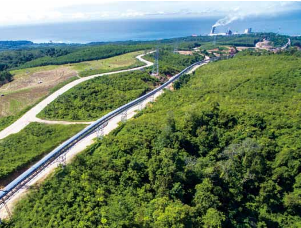
输送廊道：施工精良，气势恢宏
